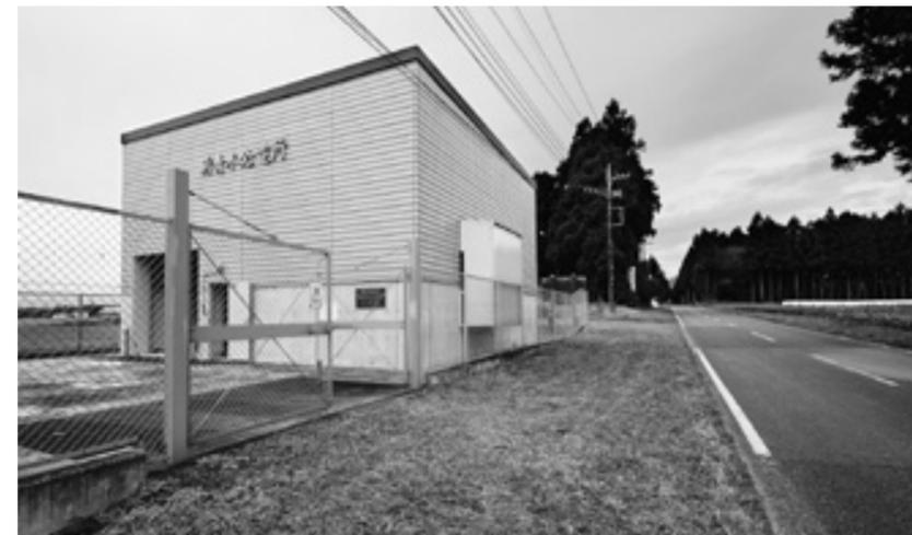
●2014年に設置された新青木発電所。右の道路の下に埋められたパイプを通して水が流れ込み最大出力500kWの電気を生み出す
