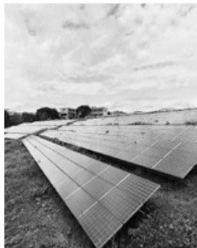
●土地改良区連合の本部前に建設された赤田太陽光発電所。1680枚のパネルで年間40万kWhの電力をつくっている
