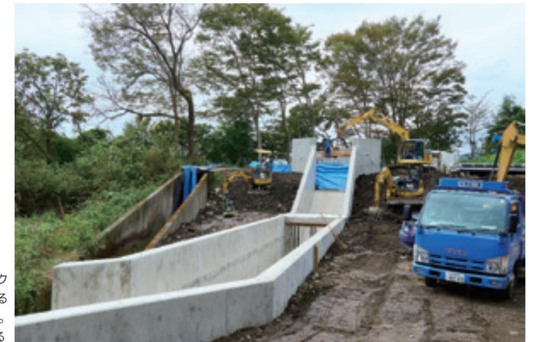
●現在建設中の折戸発電所。このコンクリート製水路の型枠を外す工程が終わるとオランダ製の螺旋水車が設置される。運転開始は2022年2月予定となっている
