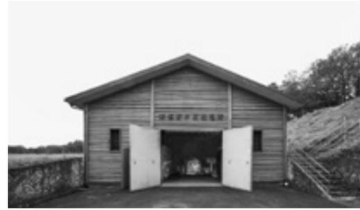
上●土地改良区連合が1992年、最初につくった那須野ヶ原発電所。右の斜面に埋められたパイプから建物内部の水車に水が流れ込む
