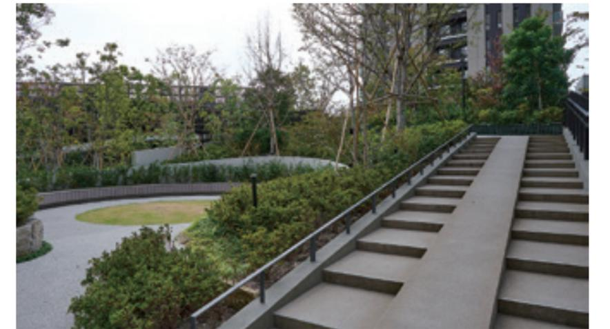
●敷地の中央部に位置する「浄水の丘」。人工地盤上に軽量土壌を用い、浄水緑地とのつながりを意識した緩やかな丘陵として整備。人工地盤の下は駐輪場となっている
