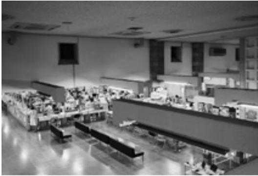
上●柱の少ないワンフロアで構成されたオフィス空間。天井に梁のように左右に伸びているのが、自然空調施設としての「風のミチ」（断面は約2m角の大きさ）。現在は使われていないが、稼働時には海側から取り込んだ涼しい風を送り出していた四角い通風口が見える
