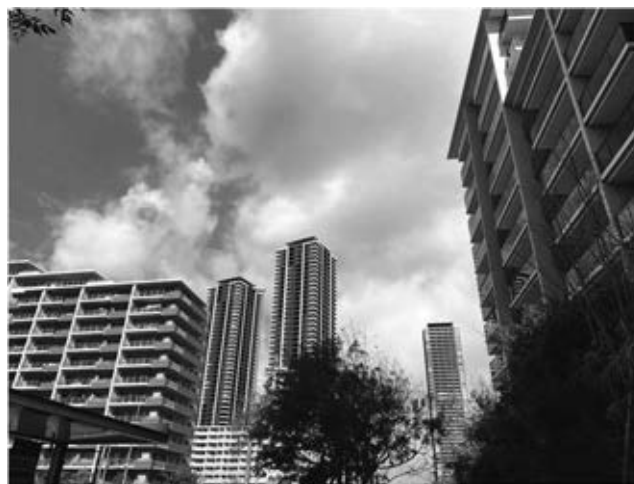
図 2.3 新築マンションが林立する香椎照葉地区 (福岡市東区, 2023 年 2 月 21 日, 筆者撮影)
