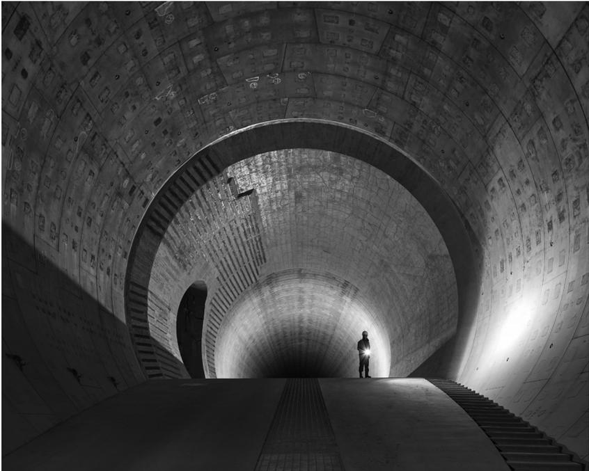
**写真1 環状七号線の地下にある調整池** 環状七号線の地下に、延長4.5km、内径12.5mのトンネルがある。豪雨災害などのとき、神田川、善福寺川、妙正寺川から洪水を流入させる。貯留量は54万 $\text{m}^3$ ある。(画像提供：東京都)
