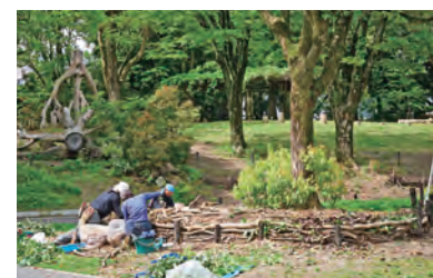
硬くなった土壌に杭を打ち、しがらを組むことで土壌に雨水がゆっくり浸透していく
